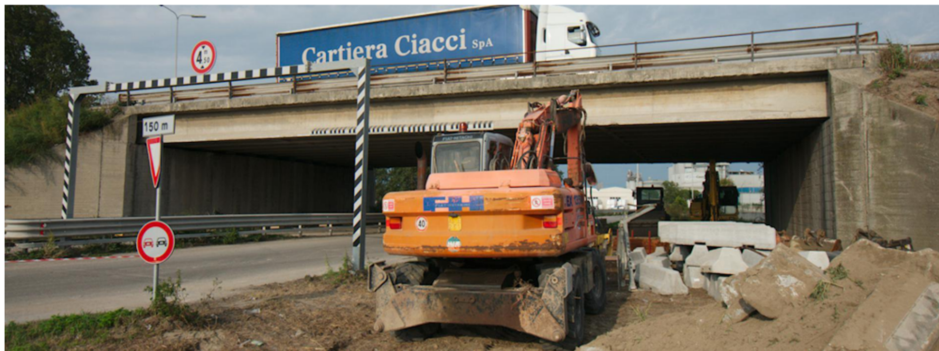
Classicana: i lavori sono pronti a partire, cantiere consegnato l'11 ottobre. Sotto, l'assessore regionale alle Infrastrutture Andrea Corsini
